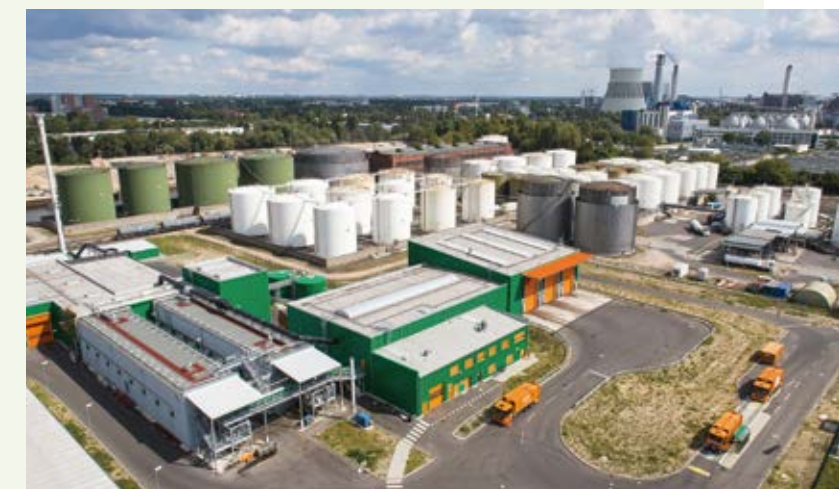
In einer der Biogasanlagen der BSR werden die Abfälle behandelt und verarbeitet
